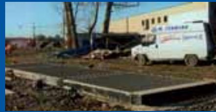
PESA A PONTE LPM 14X3 m 60 t h.40 cm. IN VERSIONE INTERRATA CON PIATTAFORMA IN CEMENTO ARMATO GETTATA IN OPERA: FASE DI MONTAGGIO ED IMPIANTO COMPLETATO
